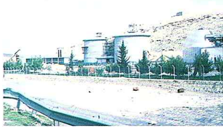
Ain Ghazal Pis Su Arıtma Tesisinin Anahtar Teslimi İnşaatı • Amman/Ürdün
