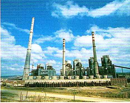
6 x 165 MW Soma - B Termik Santrali Anahtar Teslimi Yapımı
